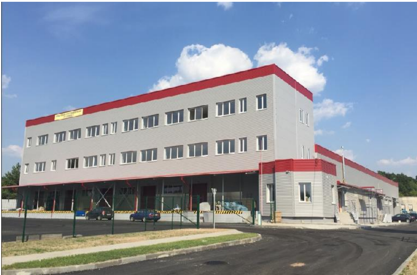
Административно-складской комплекс по адресу: г. Гродно, ул. Обухова 18
